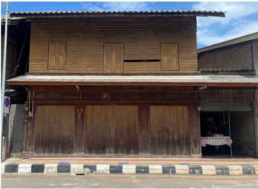
หมายเลข 50 อายุอาคาร : ประมาณ 50-80 ปี
