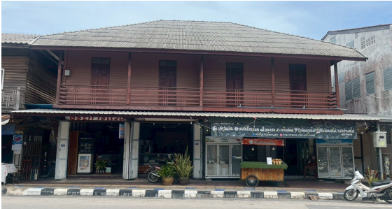
หมายเลข 75 อายุอาคาร : ประมาณ 50-80 ปี
