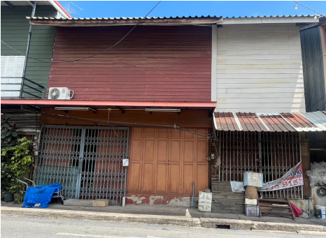
หมายเลข 78 อายุอาคาร : ประมาณ 80-100 ปี
