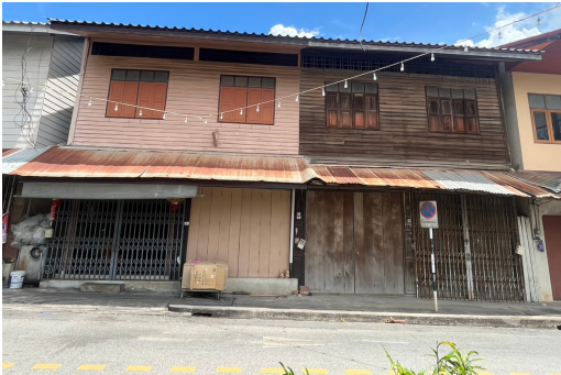
หมายเลข 79 อายุอาคาร : ประมาณ 80-100 ปี
