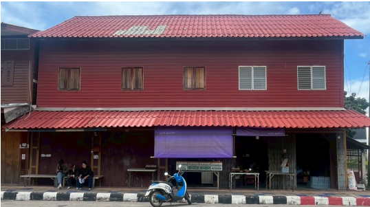
หมายเลข 36 อายุอาคาร : ประมาณ 50-80 ปี
