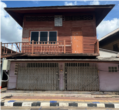
หมายเลข 51 อายุอาคาร : ประมาณ 50-80 ปี
