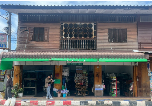
หมายเลข 38 อายุอาคาร : ประมาณ 50-80 ปี
