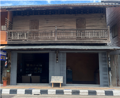
หมายเลข 49 อายุอาคาร : ประมาณ 50-80 ปี
